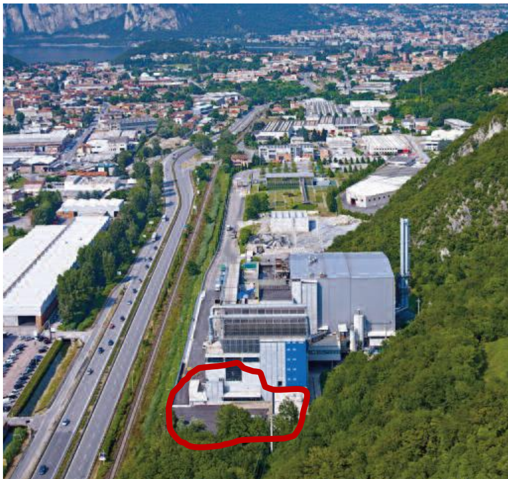
Vista in direzione Milano - Lecco
